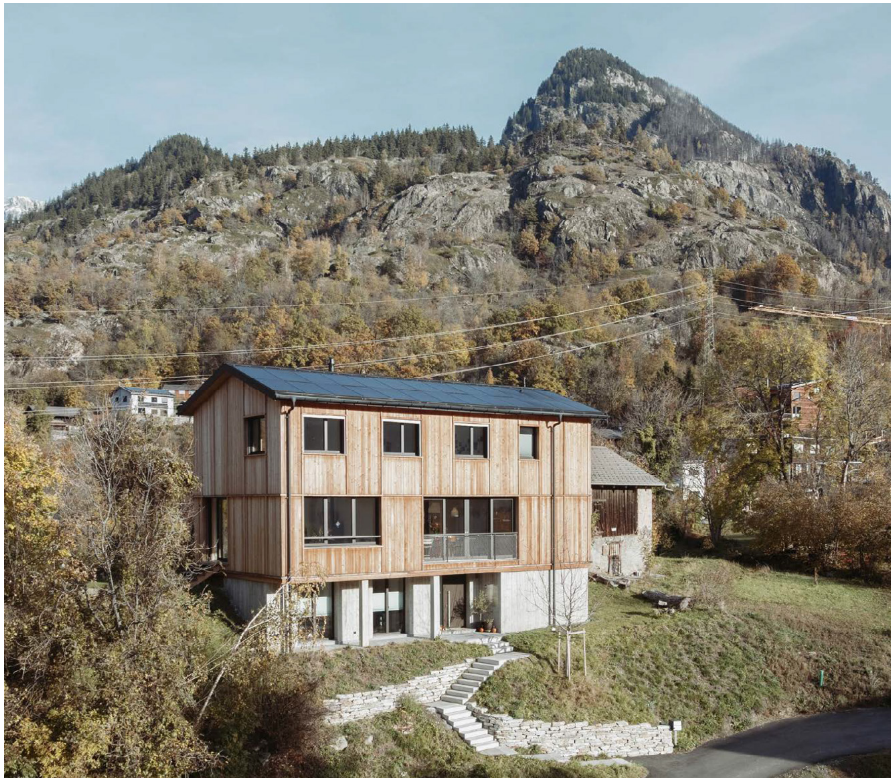
Ein von Joel Holzer und seinem Team entworfenes Einfamilienhaus in Naters.
